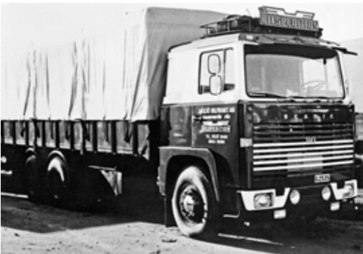
Åkeriets första LBS110. Kännetecken på tidig årsmodell; bland annat små bokstäver i emblemen och backspegelbågar med fästen endast i nederkant (här är den på högersidan dock förlängd för en extraspegel).
